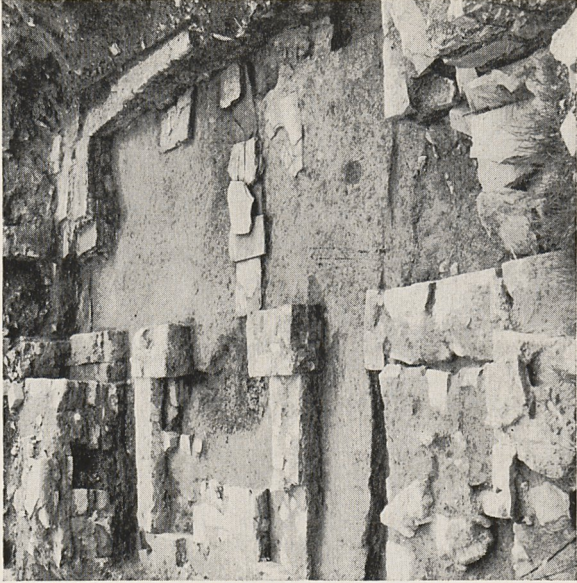
Abb. 2b Helmarshausen, Klosterkirche I. Grabungsbefund: Aufgehende Reste der Krypta von Süden
