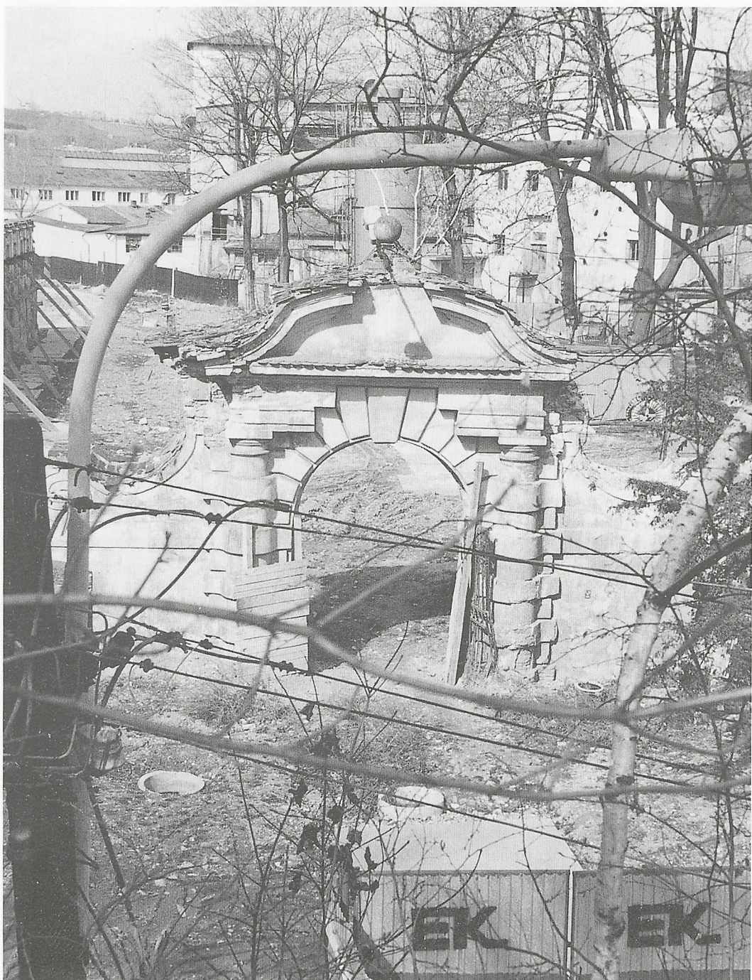
Abb. 3 Prag-Bubeneč, Portal von 1606 zum Areal der »Kaisermühle«, März 1991 (Autor)
