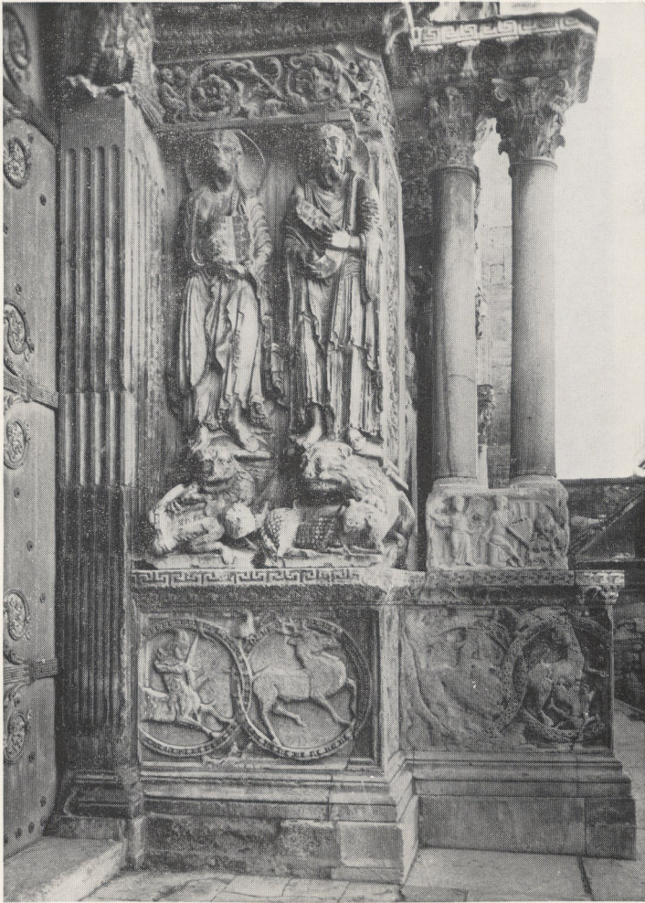
Abb. 1 Saint-Gilles, Fassade, freistehende Säulen vor dem Gewände des Mittelportals (Foto: Lechner)
