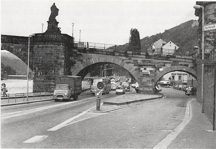
Abb. 2a Heidelberg, die beiden stadtseitigen Bogen der Alten Brücke von 1788. Zustand 1975 nach Aufweitung der Brückenbogen (Photo: Seeliger-Zeiss)
