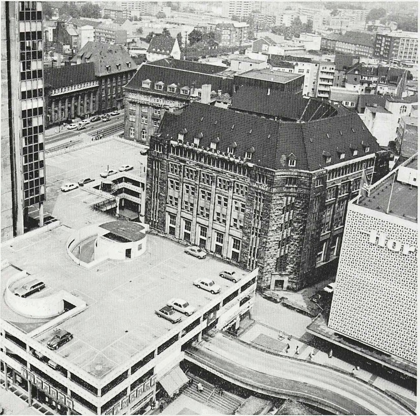
Abb. 2 Dortmund, ehem. Gebäude der Stadtparkasse. Im Vordergrund Hochgarage, rechts Kaufhaus Horten
