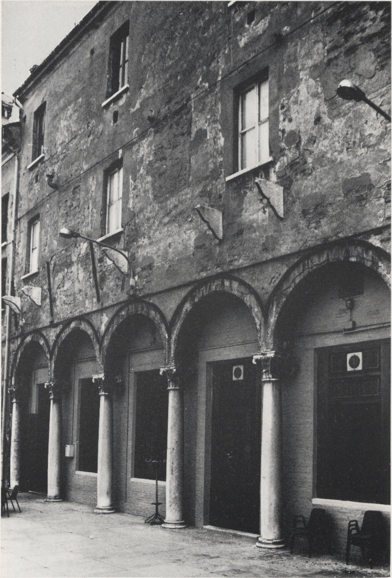
Abb. 3 Mantua, Palazzo di S. Sebastiano (Nordseite)
