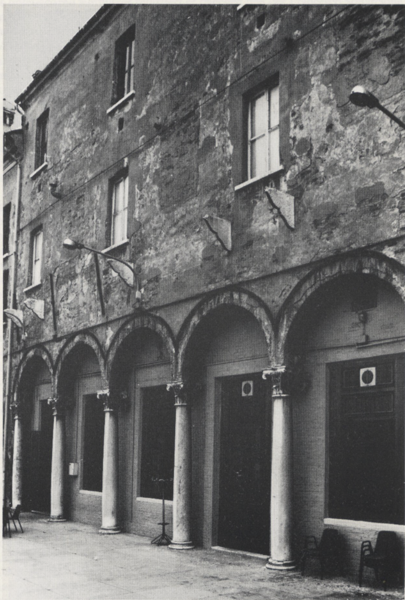
Abb. 3 Mantua, Palazzo di S. Sebastiano (Nordseite)
