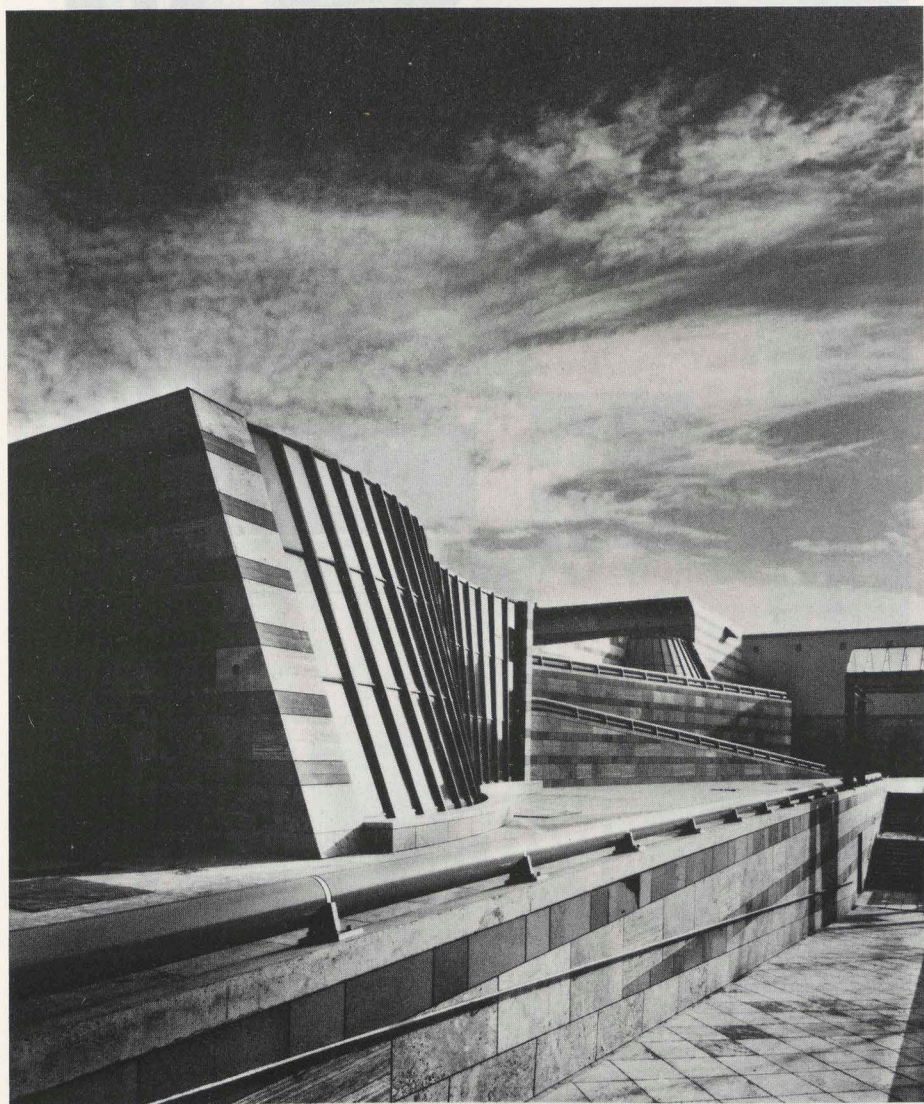
Abb. 1 James Stirling, Michael Wilford and Associates. Neue Staatsgalerie Stuttgart. Ansicht von der Konrad-Adenauer-Straße (P. Walser, Stuttgart)
