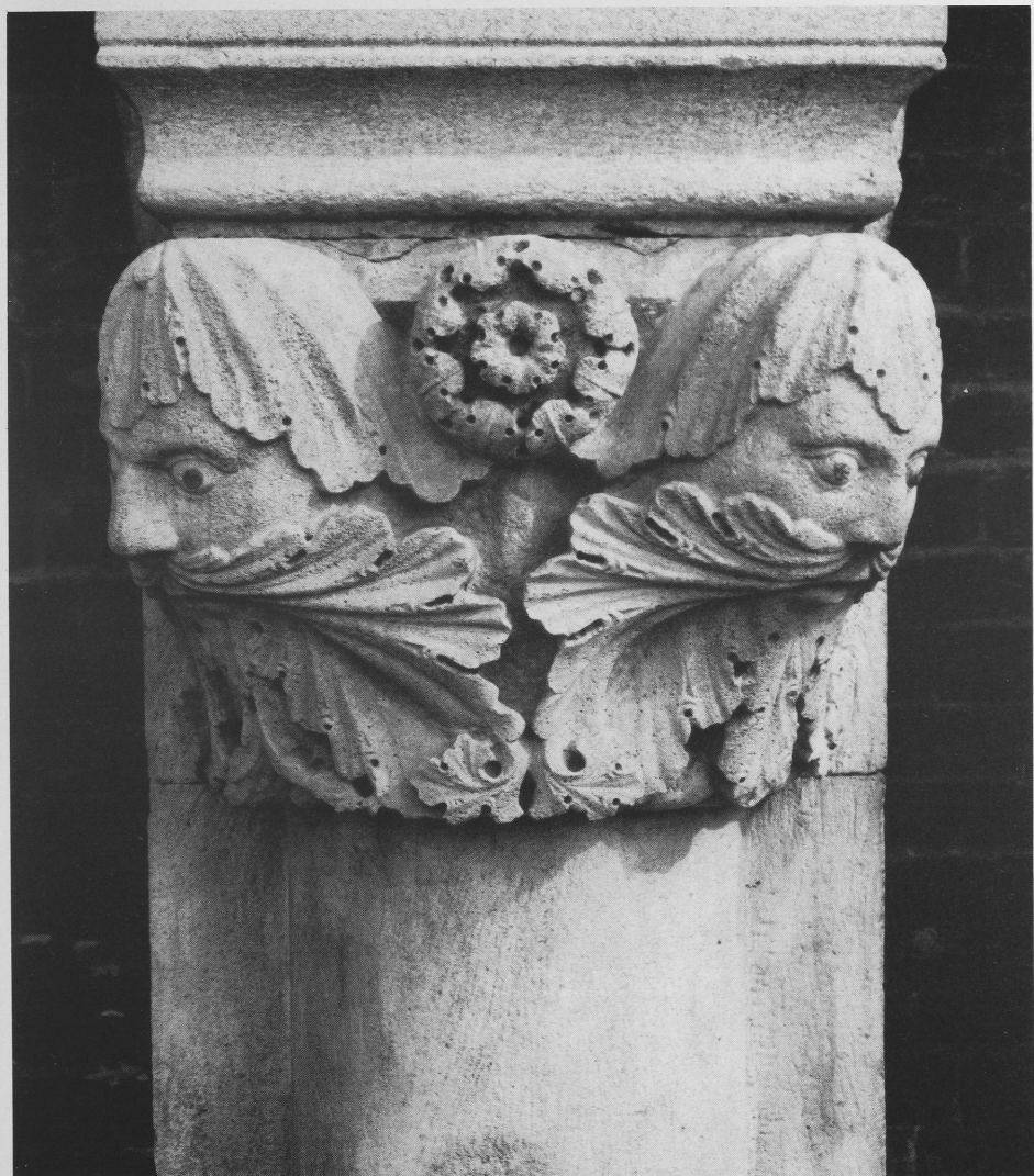
Abb. 3 Modena, Kathedrale, Kapitell der Westfassade nach der Restaurierung
