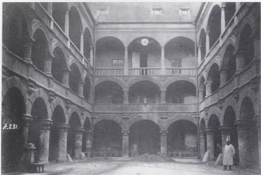
Abb. 3a München, Hof der Münze. 1565—67 für die herzogliche Kunstkammer errichtet, Zustand um 1900 (Marburg 120120)
