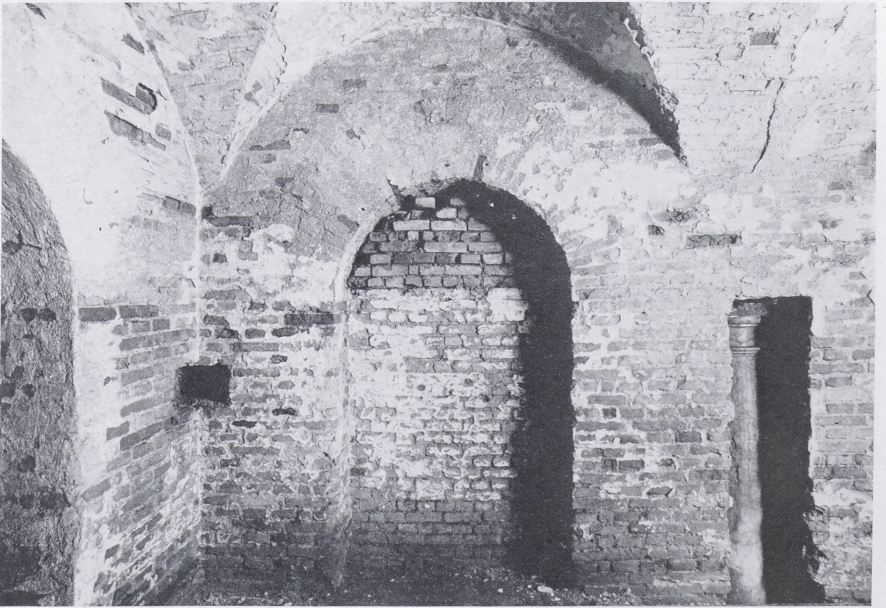
Abb. 4a und b München, Hofgarten, Arkadengebäude. Inneres mit späteren Vermauerungen und Aufschüttungen (By. Landesamt f. Denkmalpflege, E. Lantz)
