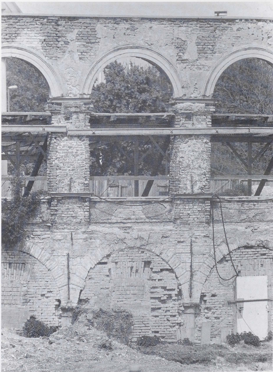
Abb. 2 München, Hofgarten, Arkadengebäude. Detail mit sichtbar gebliebenen Säulen (Diemer)
