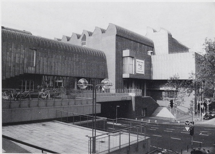
Abb. 5b Köln, Museumsneubau, Südwestansicht (Bellot)
