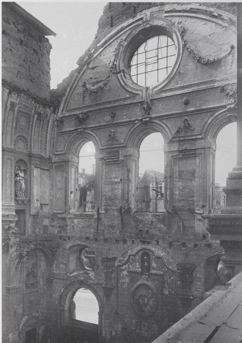
Abb. 2 München, St. Michael. Fassadenwand im September 1946 (Marburg 202024)
