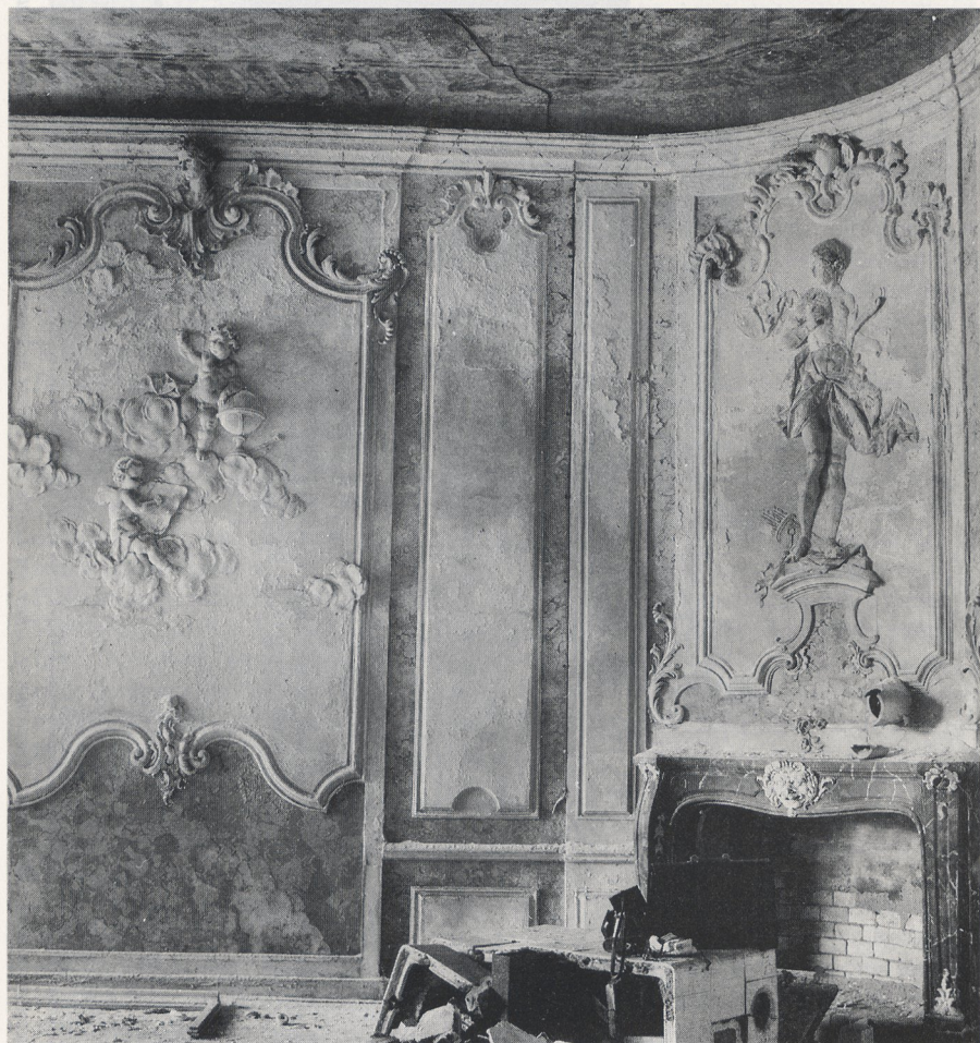
Abb. 2 Dahlemburg/Kr. Oschatz, Schloß, Weißer Saal von 1756. Beim Brand des Schlosses 1973 beschädigt. Deckengemälde von Adam Friedrich Oeser und Stuckmarmor-Dekoration der Wände in der Art Gottfried Knöfflers unbeschädigt geblieben, inzwischen durch mangelhafte Interimsabdeckung vernichtet, Zustand 1978 (IfD 27—28/579 b)
