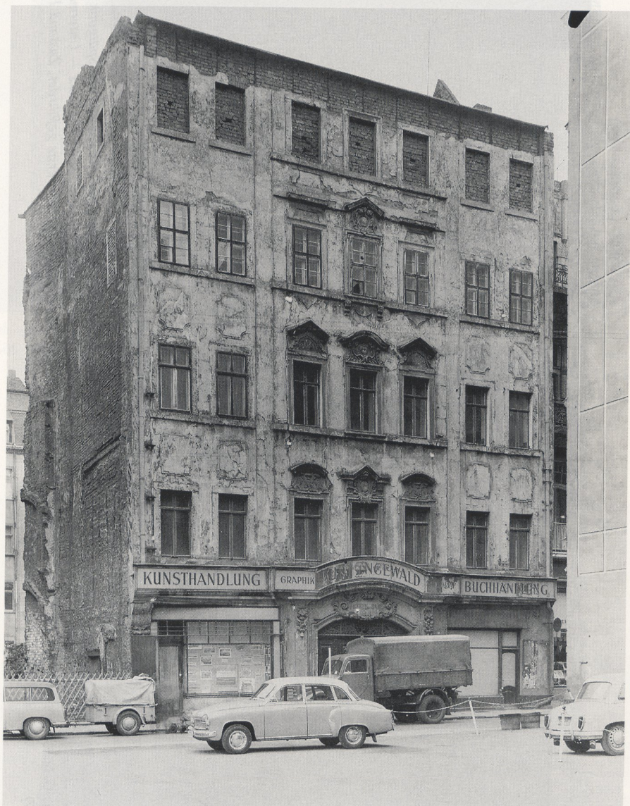
Abb. 3 Leipzig, Hotel de Saxe, Klostersgasse 9. Beispiel für eines der Bürgerhäuser in der Innenstadt, die abgebrochen wurden, Zustand 1967 (IfD 17—18/662)
