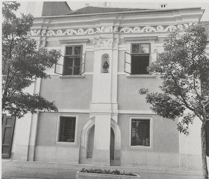
Abb. 12b Kőszeg (H), Wohnhaus Jurisichplatz 12, rekonstruierte Fassade mit dem Tor der ersten Bauperiode (M. György, Budapest)
