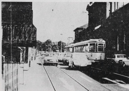
Abb. 3c Bonn, Bahnhofstraße; links die künftige Bauungsgrenze nach dem inzwischen begonnenen Projekt (Fotomontage)
