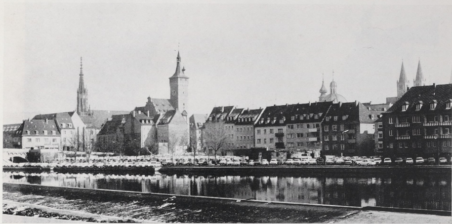
Abb. 4a Würzburg, Mainfront östlich der Alten Mainbrücke; das Areal des zerstörten Wohnviertels an der Uferstraße bisher als Parkplatz benutzt
