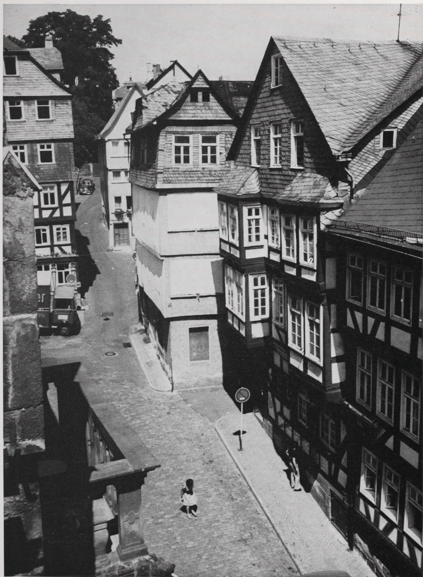
Abb. 1 Marburg, Obermarkt, Ensemble sanierter Fachwerkbauten
