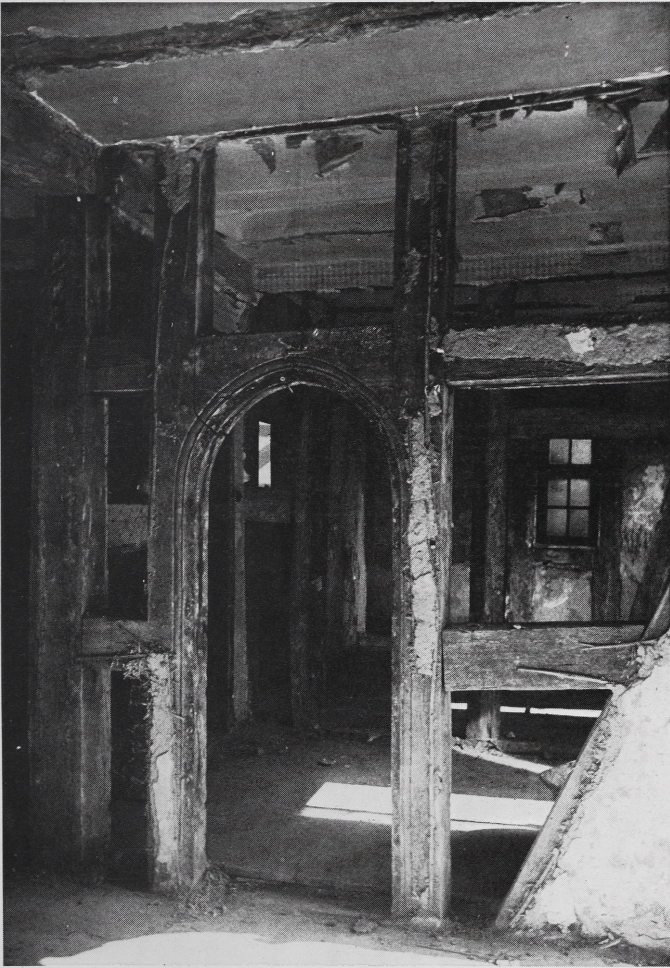
Abb. 3 Marburg, Fachwerkhaus (um 1530). Jedes Fachwerkhaus wird auch im Innern freigelegt, so daß das Holzgerüst völlig zugänglich wird. Dabei kommen die bis dahin vom Putz verdeckten alten Türen zum Vorschein
