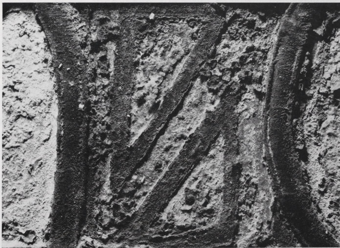
Abb. 6b Regensburg, Dom, Jesse-Fenster (2. Viertel 13. Jhr.). Ausschnitt: Inschriftband im Aufsicht; Zustand 1974 mit sich ablösender Schwarzlotbemalung (Foto: G. Frenzel)
