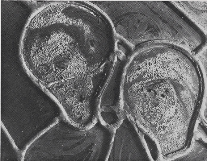
Abb. 6a Ausschnitt wie Abb. 5a. Zustand 1975, in Aufsicht aufgenommen, um die Verwitterungserscheinungen sichtbar zu machen
