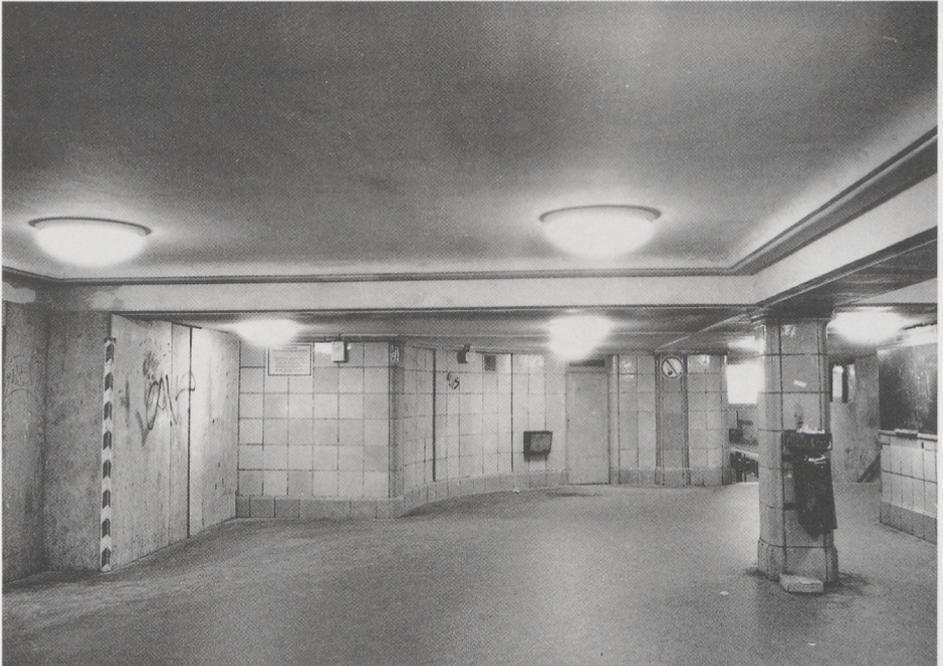
Abb. 3 Berlin, U-Bahnhof Hermannplatz während der Renovierung 1992/93. a: Der zweite Pfeiler von vorn ist bereits neu verkleidet – b: originales Kapitell, Grenander 1926 – c: Vorhalle mit sorgfältiger Durcharbeitung der Wände (G. Kohrmann, Bamberg)
