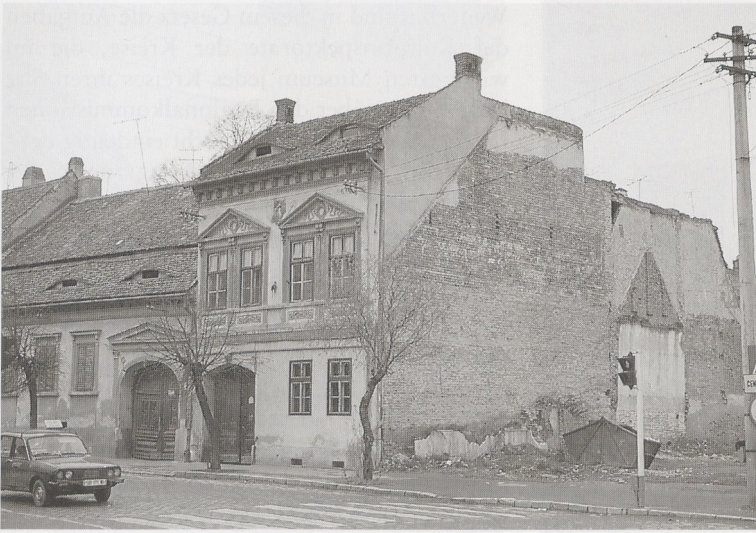
Abb. 6 Hermannstadt, bis hierhin reichte der 1985 begonnene Abbruch von Häuserblocks an der Salzgasse/Str. Constituției (Autorin)
