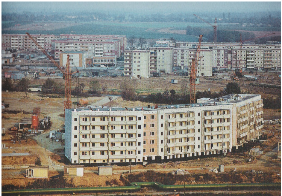
| Abb. 3 | Baustelle mit einem fünfgeschossigen Gebäude der Wohnungsbauserie WBS 70/5 in Berlin-Marzahn (1979). Meuser 2022, Teil 1, S. 259
