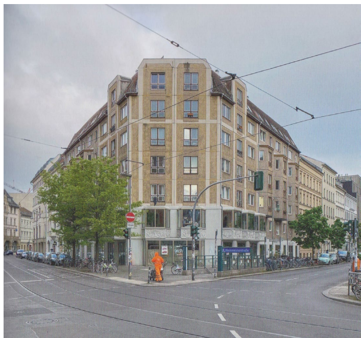
| Abb. 6 | Neue Schönhauser Straße/Ecke Weinmeisterstraße (2020). Meuser 2022, Teil 2, S. 235
