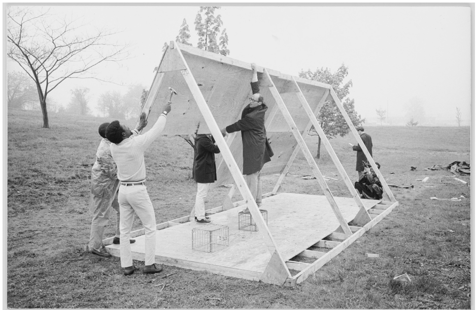
Abb. 4 | Probeaufbau einer A-Frame-Hütte (Typ A). In der Mitte: Architekt John Wiebenson. Washington, D.C. 1968. Foto © Thomas O'Halloran, 1968, Collection of the Smithsonian National Museum of African American History and Culture. Public domain
