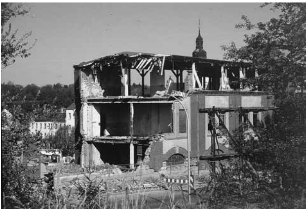
Hauptgebäude der Werdauer Maschinenfabrik Carl Eli Schwalbe (Ostflügel) während des Teilabrisses, April 2009.
