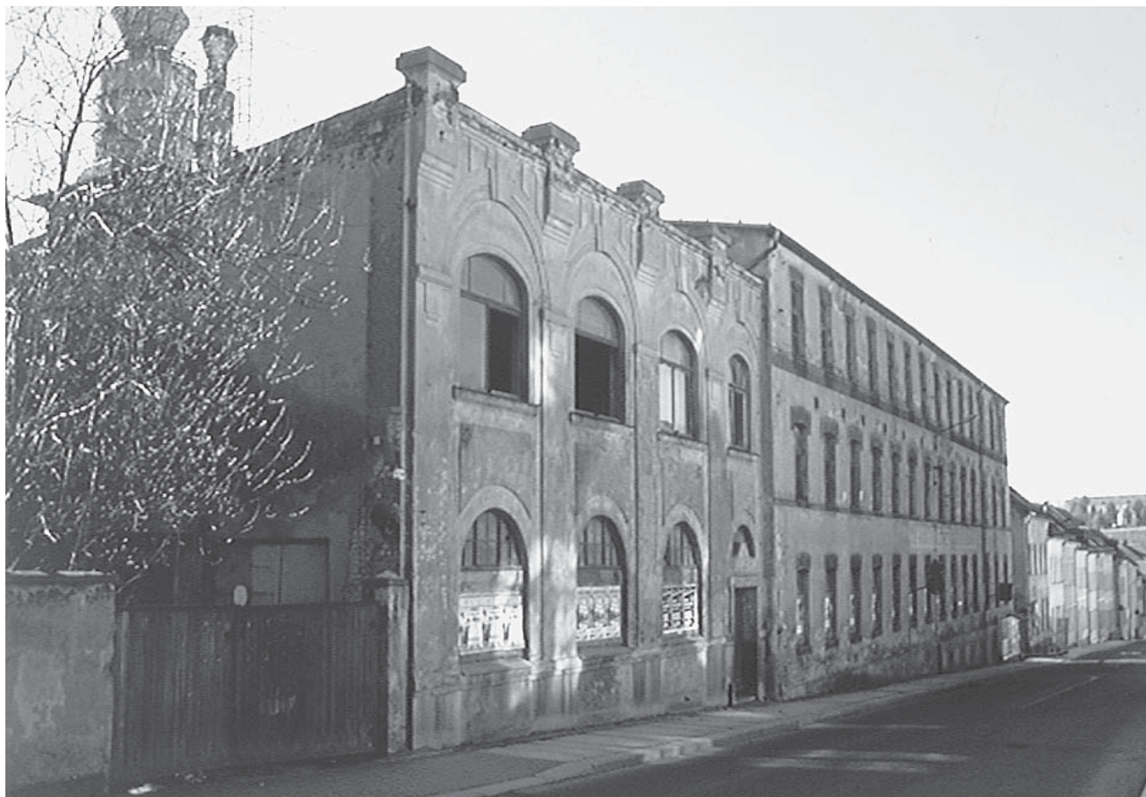
Verwaltungs- und Fabrikgebäude der ehemaligen Werdauer Orgel- und Harmoniumfabrik, Zustand vor dem Abbruch, Frühjahr 2007.
