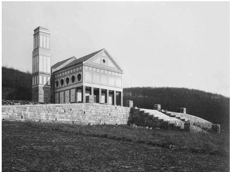
Abb. 1: Das Krematorium in Hagen-Delstern, Außenansicht, Entwurf: Peter Behrens (historische Aufnahme, © Bildarchiv Foto Marburg).
