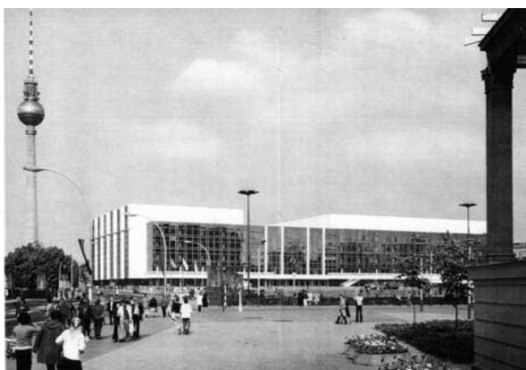
Abb. 11: Berlin, Palast der Republik , Ansicht von Unter den Linden (Westen). (Foto: Gerhard Murza, in: Graffunder 1977, Palast , Abb. 4)
