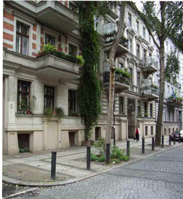
Abb.2: Sanierete Fassaden in der Neufertstraße, Foto: T. Kiepke, 2005.
