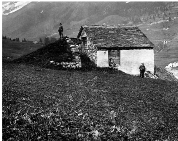
Abb.27: Lawinenschutz in Form von so genannten Spaltmauern vor Häusern in Tallagen (Coaz 1910, Statistik , Abb. XXII).
