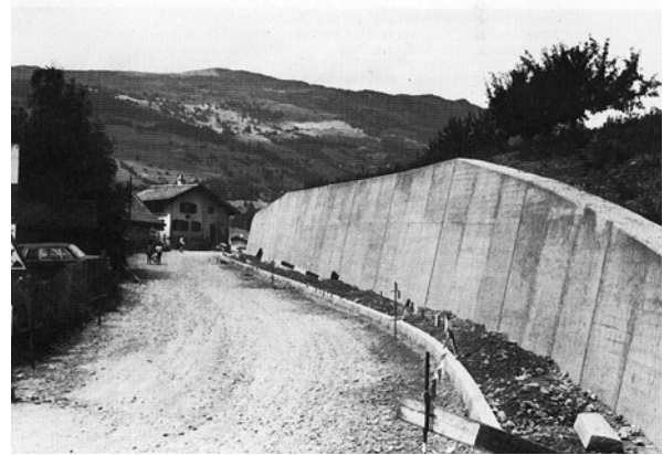
Abb.23: Betonmauern zur Ersetzung straßenbegleitender Bruchsteinmauern im Dorf- und Stadtkontext (Weiss 1981, Zerstörung , S. 162).
