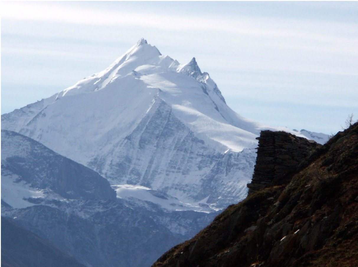
Abb.40: Fernsicht auf die Lawinenschutzmauern der Faldumalp (Falser 2007).
