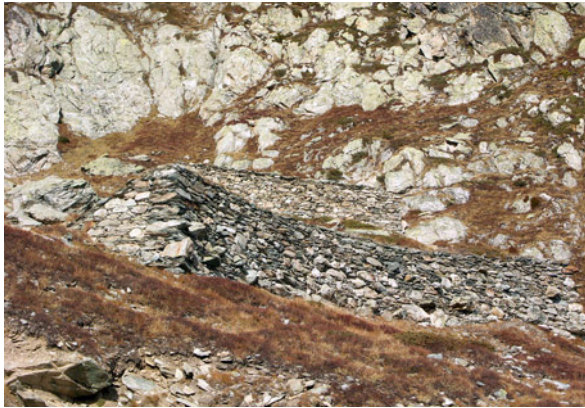
Abb.18: Historische Lawinenschutzmauern und ihre Einbettung in die lokale Topographie und Materialumgebung (Falser 2007).
