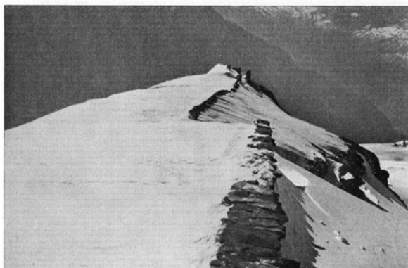
26. 4. 1932 Abb. 10 E. Hess, Bern Gwächtenmauern 46 und 46 A eingeschnitten
