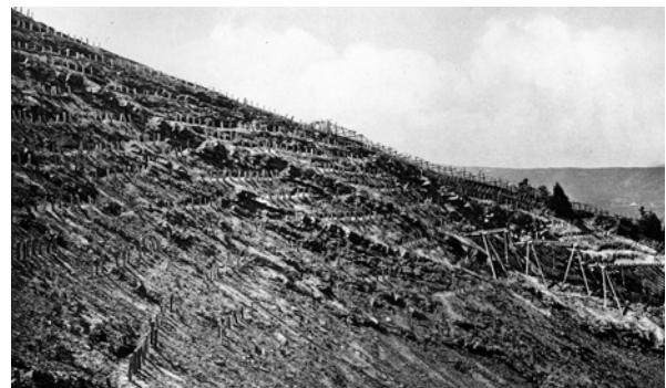
Abb.3: Verpfählungen und Schneebrücken in Höllbach, Kanton Freiburg (Coaz 1910, Statistik, Abb.XXI).
