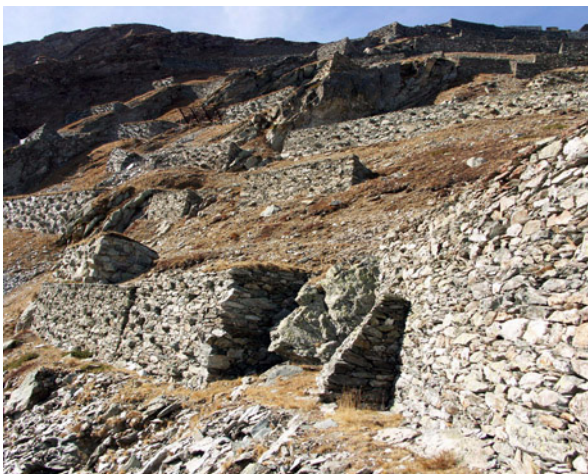
Abb.25: Der Wehrcharakter von Lawinerverbauungen aus Trockenmauerwerk an hohen Berghängen (Falser 2007).
