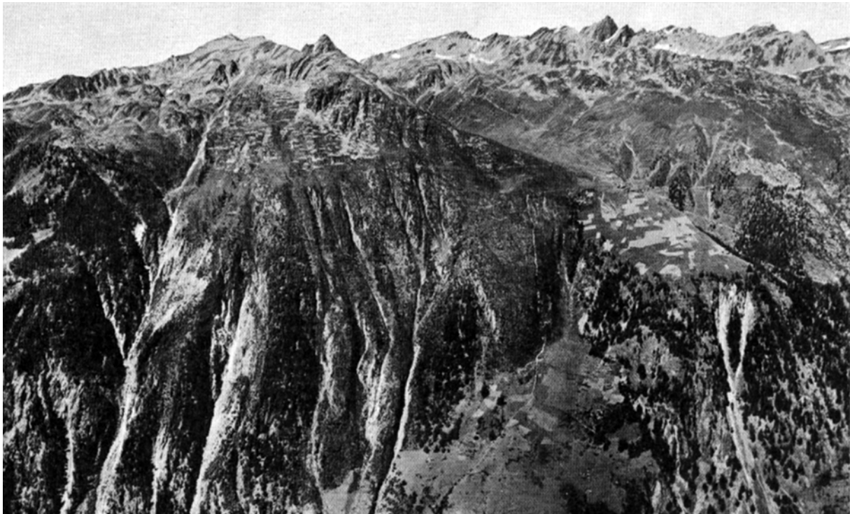
Abb.1: Faldumalp oberhalb der Bahnstation Goppenstein auf der Bern-Lötschberg-Simplon-Strecke, Wallis. Die Lawinenschutzmauern sind in der oberen linken Bildmitte als dünne weiße horizontale Linien auszumachen (Schädlein 1934, Lawinerverbauungen , S. 4).
