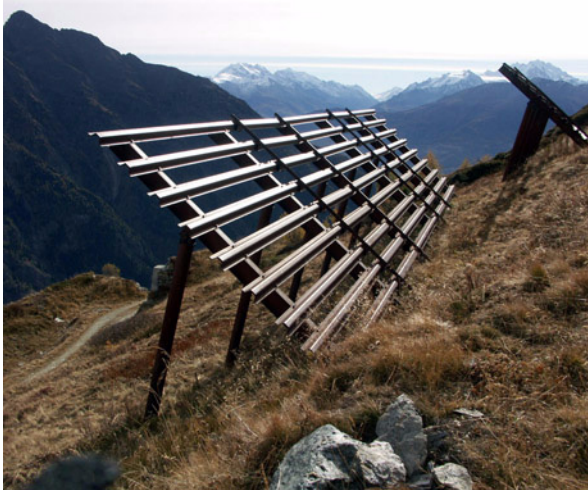
Abb.22: Neue Stahlbrücken als Lawinenschutz anstelle der ehem. Trockensteinmauern in freier Landschaft (Falser 2007).
