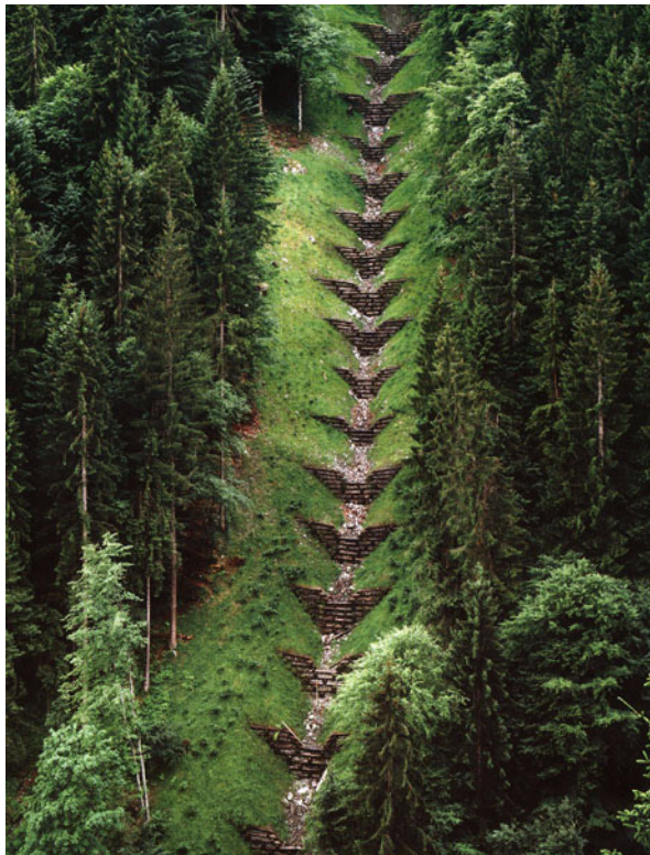
Abb.35: Holzkastensperren (Divjak 2006, Interventionen , Bild 15).
