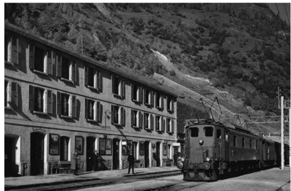
Abb.16: Abb.17: Der Bahnhof Goppenstein mit bewehrtem Tunnelportal (oben) und Bahnhofsgebäude und Lawinleitmauern unmittelbare hinter der Station hinauf Richtung Faldumalp (1988) (Patric Belloncle, Peter Willen, BLS – Die große Alpenbahn 75 Jahre Bern – Lötschberg – Simplon Bahn 1913-1988 , in: Eisenbahn Zeitschrift (Sonderausgabe), Köniz 1988, S. 48).
