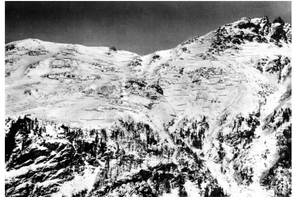
Abb.26: Mit Stahlbrücken verbaute Hänge oberhalb von Pontresina (Coaz 1910, Statistik , Abb. XVIII).
