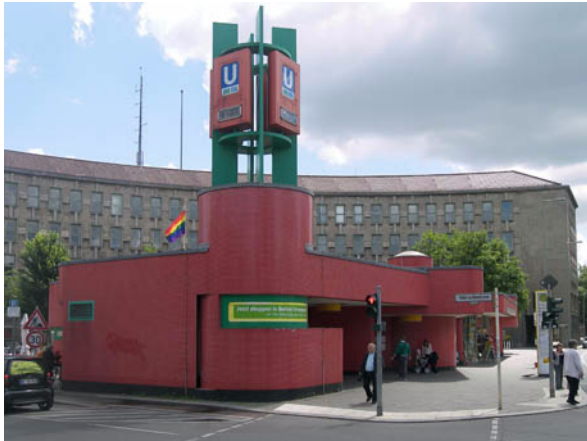
Abb.1: Eingangsgebäude Fehrbelliner Platz, Berlin.
