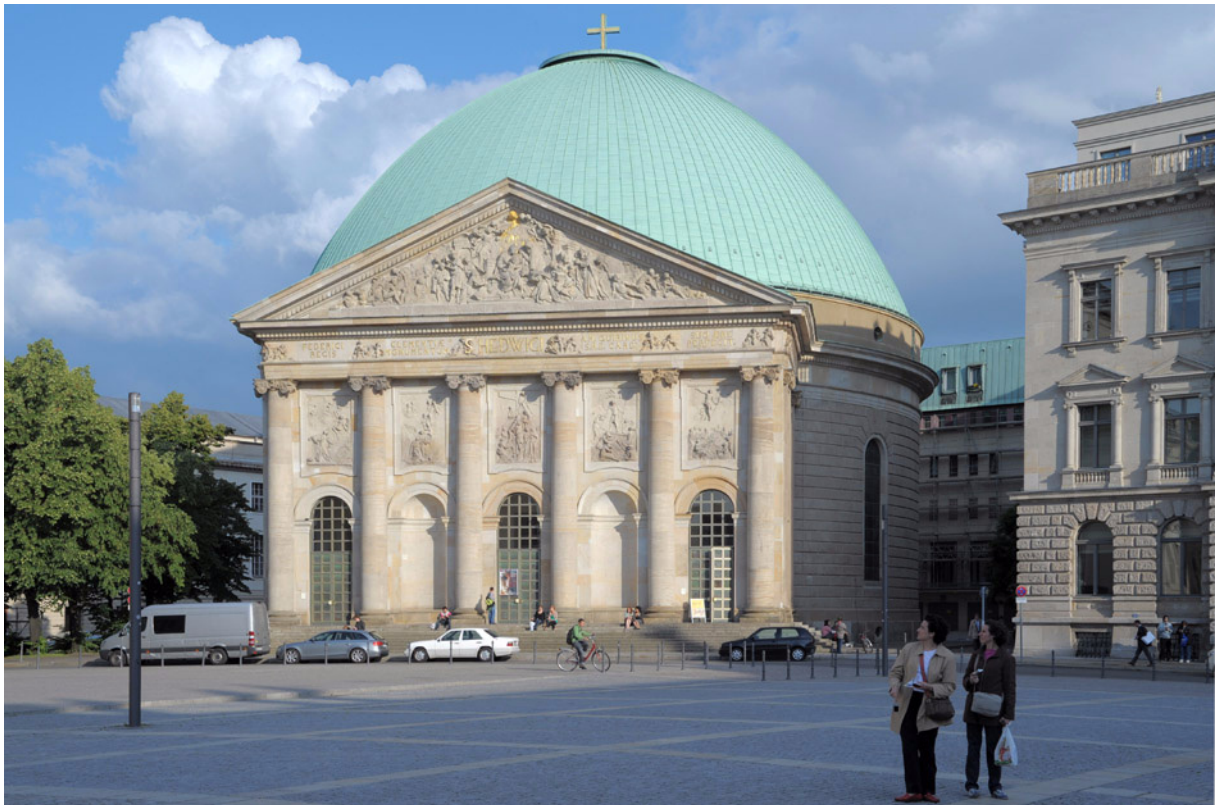
Abb.2: St.-Hedwigs-Kathedrale Berlin, Wiederaufbau nach dem Zweiten Weltkrieg. Foto: Wolfgang Bittner, Landesdenkmalamt Berlin.
