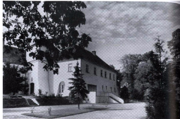
Abb.8: Umbau eines Schlosses, Brezí u Týna nad Sázavou, 1936.
