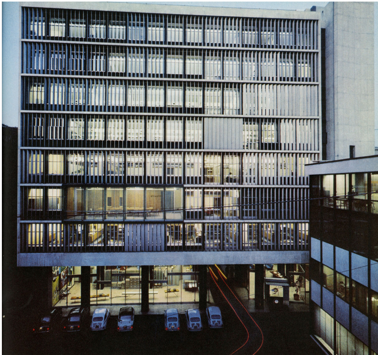
Abb. 10: Annibale Focchi mit Gian Antonio Bernasconi und Marcello Nizzoli, Olivetti-Verwaltungsgebäude Mailand, 1950-1954, in Soavi 1958, S. 133.
