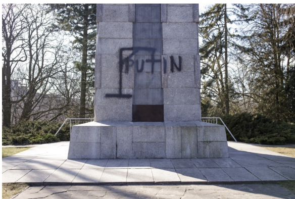
Fig. 4: Interventions on the Monument to Heroes in the Poznań Citadel after February 2022. Photo: Lukasz Cynalewski (Agencja Wyborcza.pl).
