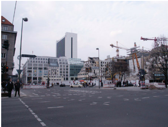
Abb.12: Unter den Linden/Friedrichstraße. Nordseite der Kreuzung. Rechts: Abriss des Lindenhotels von 1966. Im Hintergrund das Hochhaus am Bahnhof Friedrichstraße. Die anschließende Bebauung im Hintergrund hat die historische Bauflucht bereits wiederhergestellt. April 2006, Foto: Rocco Curti.
