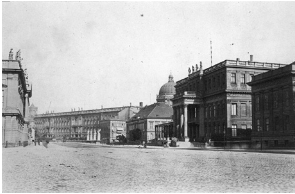
Abb.9: Unter den Linden, Blick auf das Stadtschloss, rechts im Vordergrund das Kronprinzenpalais mit Prinzessinnenpalais. Im Hintergrund die Schlosskuppel, davor das Kommandantenhaus (Bildmitte) mit Walmdach, um 1885 (Frecot 1984, Frühe Photographien , S. 24).
