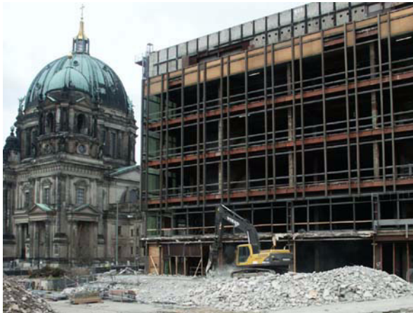
Abb.11: Abriss Palast der Republik, Fassade am Schlossplatz. April 2006, Foto: Rocco Curti.
