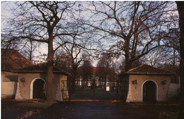
Abb. 3: Torhäuser Tschaikowskistraße (U. Schwartz, 2000)
