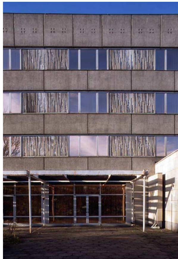
Abb. 8: Fassadendetail Appartementgebäude (U.Schwartz, 2000)
