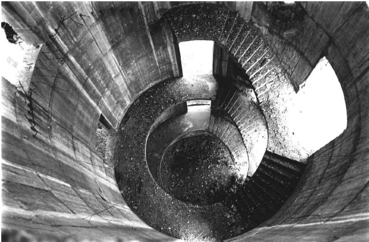
Abb. 9: Innenraum des nördlichen Schornsteins mit Treppenläufen (unvollendet), Fotografie: Gerold Eßer, 2001.
