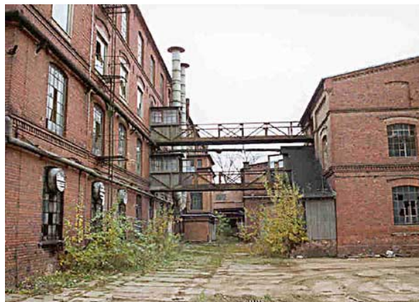
Abb. 8: ehemalige Tuchfabrik Friedrich Schmidt, Hauptproduktionsgebäude (links) mit Stegen zum ehemaligen Tuchlager.
