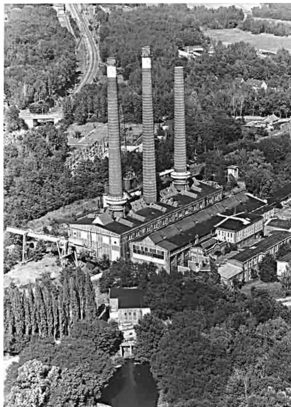
Abb.: Bahnkraftwerk Muldenstein, Fotografie: Reinhard Ulrich, Landesamt für Denkmalpflege Sachsen-Anhalt, August 2001.
