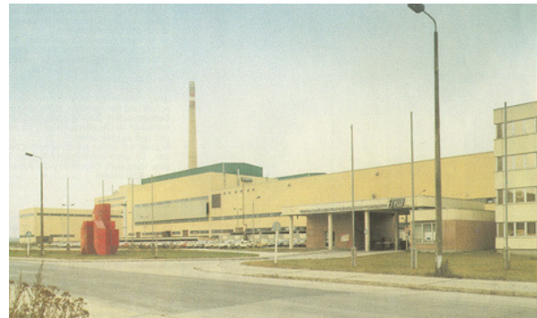
Abb.2: Tschernitz, Fernsehkolbenwerk, 1982-1984, von links nach rechts: Scherbenlagerhalle, Gemengeaufbereitung, Wannenhallen mit Schornstein, Weiterverarbeitungsgebäude, Eingangsbauwerk mit Buswartehalle, Verwaltungsgebäude
