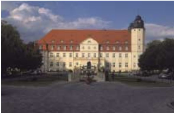
Abb.1: Göhren-Lebbin, ehemaliges Gutshaus Blücher, Ansicht der Eingangsseite mit davorliegender Tiefgarageneinfahrt, Foto: Nils Meyer.
