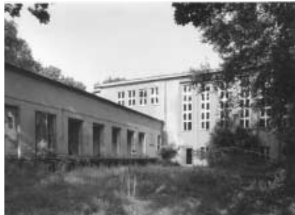
Abb.4: Netzersatzgebäude (rechts), Trafogebäude (links), Foto: Wolfgang Bittner, 27.8.2002.
