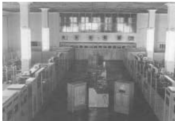
Abb.11: Sendergebäude, Sendersaal, rechts und links je ein 250-kW-Mittelwellensender, aus: Hermann 1994, Entwicklung , S. 165.
