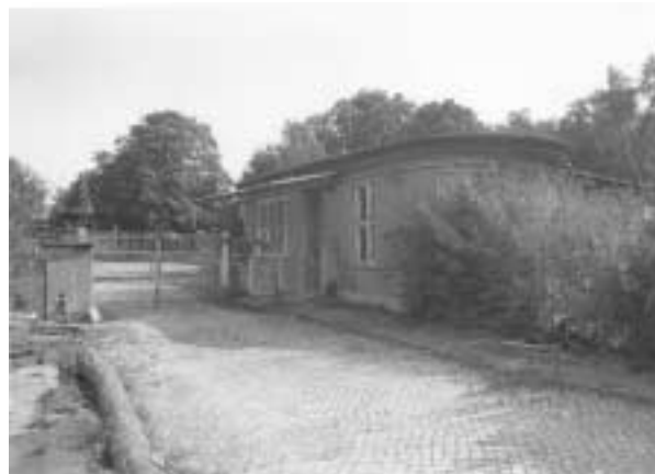
Abb.9: Pförtnergebäude, Foto: Wolfgang Bittner, 27.8.2002.
