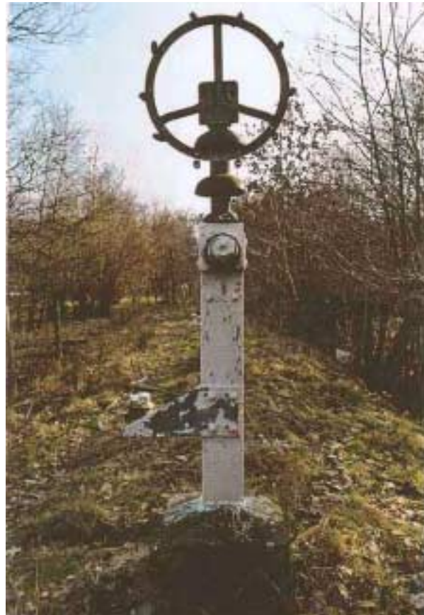
Abb.13: Reusenanlage, Detail, Foto: Ute Jochinke, 17.2.2002.
