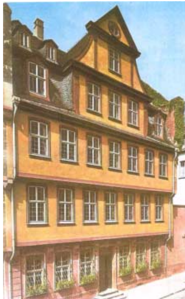
Abb.7: Goethes Geburtshaus in Frankfurt am Main, Foto: Archiv Eckart Rüsich.
