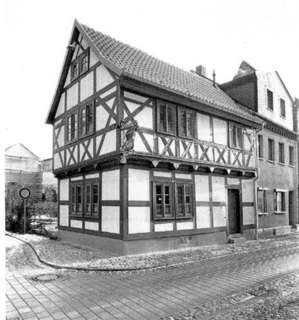
Abb. 3: Aschersleben, Hinter dem Turm 24, Zustand des Wohnhauses 1999, Fotografie: Landesamt für Denkmalpflege Sachsen-Anhalt.
