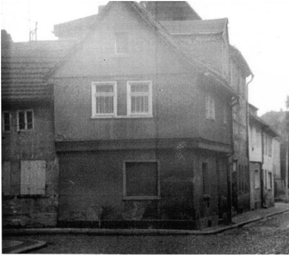
Abb. 1: Aschersleben, Hinter dem Turm 24, Zustand des Wohnhauses 1985, Fotografie: Mathis Nitzsche.
