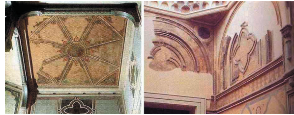
Abb. 20, 21: restaurierte Deckenbemalung und Wandstuck im großen Treppenhaus, 1995, Ausschnitt, aus: Simon 1995, Neue Synagoge , S. 82
