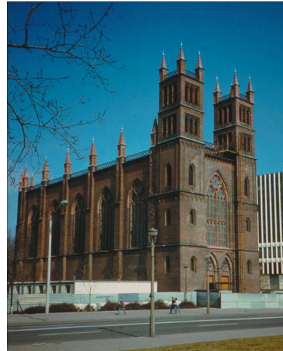
Abb. 8: rechts: Die Friedrichswerdersche Kirche nach Abschluss der Arbeiten am Äußeren, um 1986, Robert Graefrath
