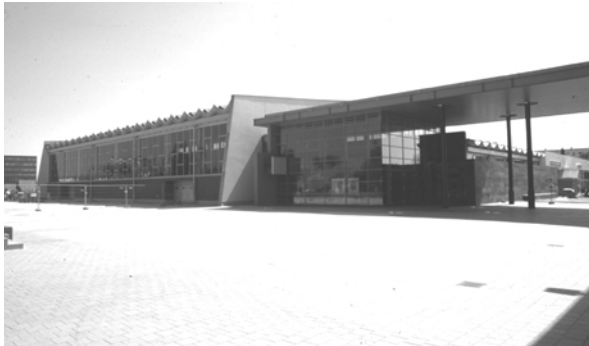
Abb.10: Leinefelde, Mehrzweckhalle des ehem. Versorgungszentrums», heute «Obereichsfeldhalle», err. 1971-74, Umbau und Sanierung des Foyers 1998-2000 (Foto: U. Wieler).
