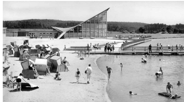
Abb.4: Hohenfelden, Naherholungsgebiet, Badestrand und Gaststättengebäude, err. ab 1965 (aus: Deutsche Architektur 1/1973).
