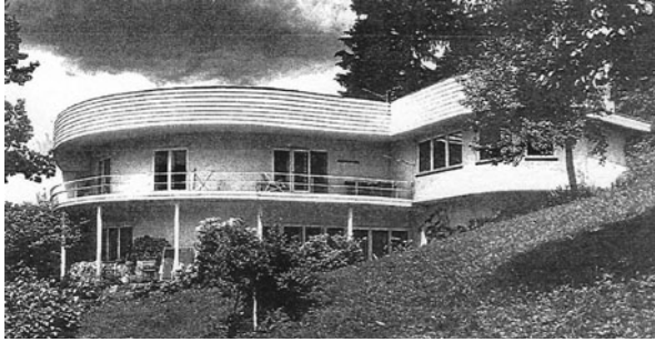
Abb.42: Haus Heyrovsky, Balkonansicht, Lois Welzenbacher, 1932.
