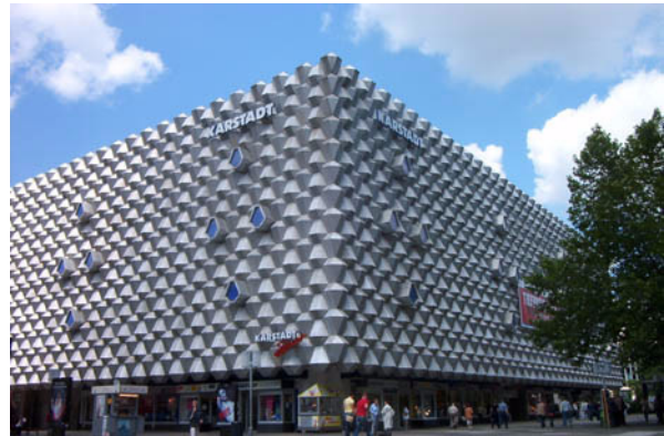
Abb.18: Karstadt-Warenhaus , von Südosten, 2004.
