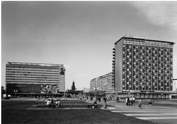
Abb.9: Blick vom Wiener Platz nach Norden in die Prager Straße, 1976. Im Vordergrund das Interhotel «Newa».
