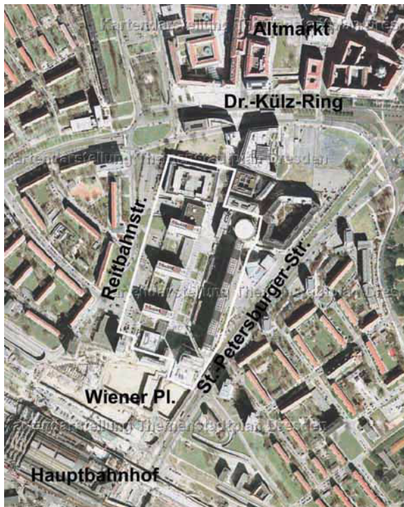
Abb.1: Lage und Abgrenzung des historischen Ensembles Prager Straße , Luftbild Ende 1990er Jahre. Im Süden die Baustelle Wiener Platz.
