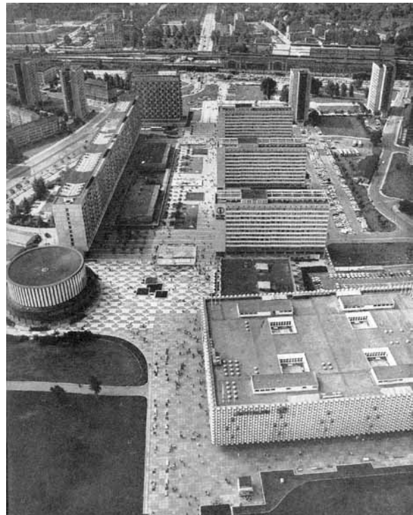
Abb.3: Gesamtansicht von Norden, etwa 1979. Im Vordergrund das Baufeld des dritten Bauabschnitts ( Haus des Lehrers ).
