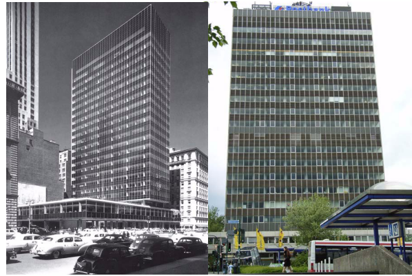
Abb.4: Lever Building, New York, Aufnahme um 1952 (links). Postbank (ehem. Postscheckamt), Aufnahme 2005 (rechts).
