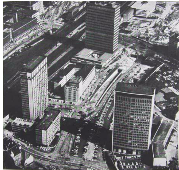
Abb.2: ThyssenKrupp, Postbank, RWE-Hauptverwaltung. Luftbild. Aufnahme 1968.
