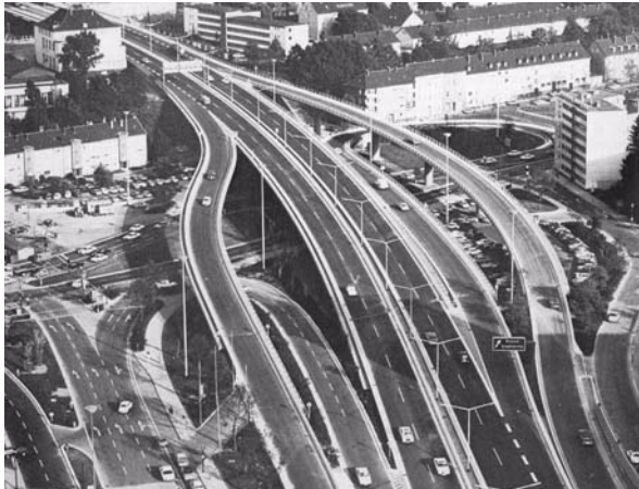
Abb.1: Helbingbrücken, Luftbild, Aufnahme 1970.
