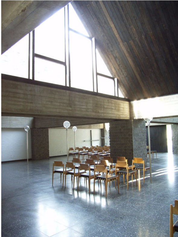
Abb.8: Innenraum. Dachraum und Deckenträger. Aufnahme 2005.
