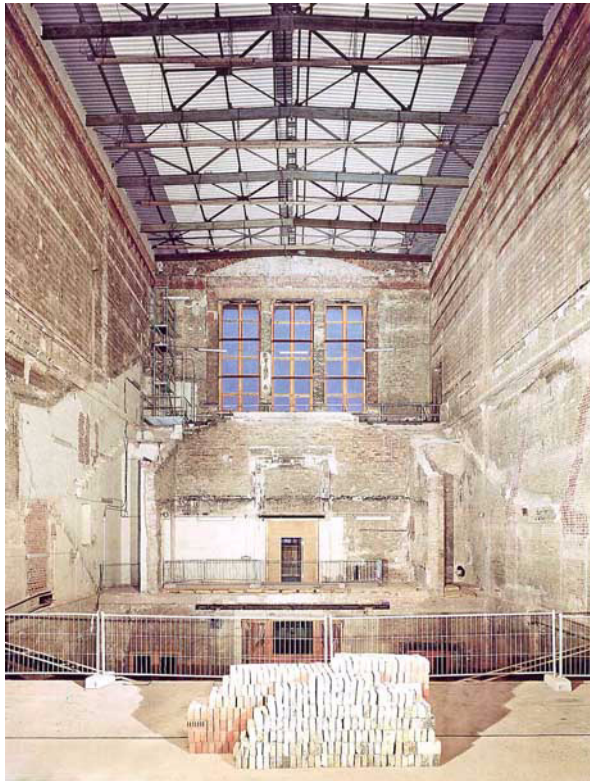
Abb.11: Baustelle Treppenraum im Neuen Museum Berlin.
