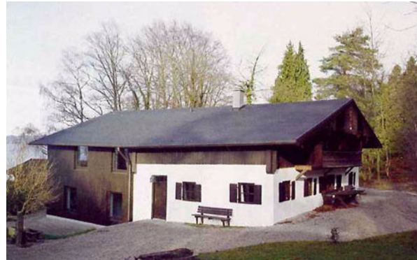
Abb.2: Neubau ehemaliger Wirtschaftsteil, asymmetrische Fassadengliederung, in die Wände verschiebbare Fenster und Fensterläden.
