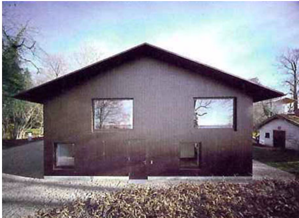
Abb.3: Westgiebel des erneuerten Wirtschaftsteils, statt auf den Balkon hinauszutreten, schiebt man nun das große Fenster in eine Wandnische und «lässt die Natur ins Haus»
