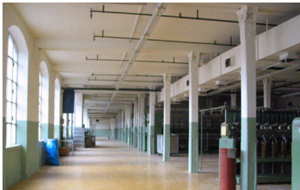
Abb.6: Spinnerei Otto, Bestand Innenraum mit Stahlkonstruktion und Kapitell.
