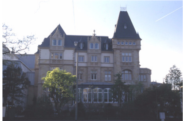
Abb.10: Frankfurt am Main, Villa Speyer nach der Teilrekonstruktion, Straßenfassade der Villa Kennedy.
