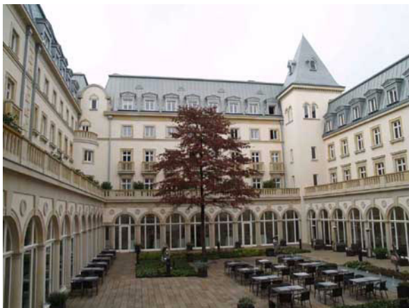
Abb.9: Frankfurt am Main, Innenhof der Villa Kennedy.
