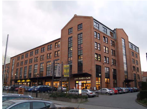
Abb.13: Hamburg-Bahrenfeld, Neubau einer Ladenzeile gegenüber der Reinigungshalle des Alten Gaswerks.
