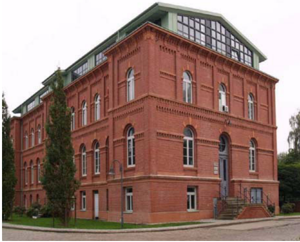
Abb.12: Hamburg-Bahrenfeld, Altes Gaswerk, Verwaltungsgebäude, 1892-95, Sanierung und Umbau der 1990er Jahre.
