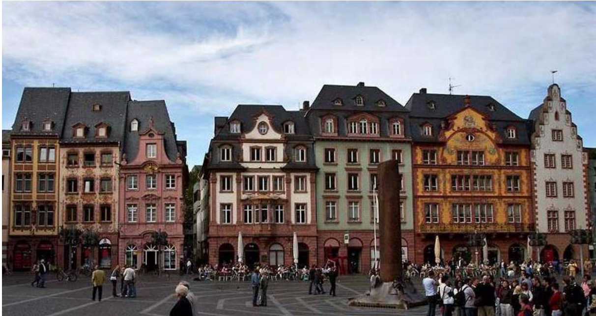
Abb.1: Mainz, Nordfront des Marktplatzes, Rekonstruierte Fassaden der frühen 1980er Jahre, in der Mitte das Haus zum Fuchs.
