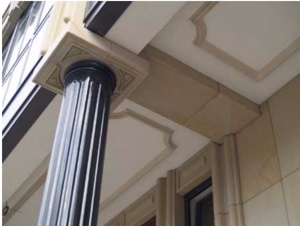
Abb.20: Hamburg, Störtebekerhaus, Architektenteam Tipke, 2005, Detail.
