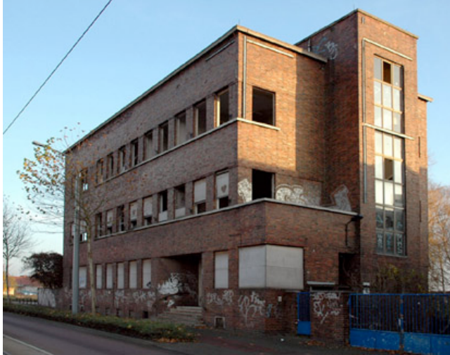
Junkalor-Verwaltungsgebäude in Dessau
